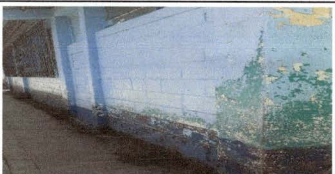
Foto 6: Pintura en muros exteriores
