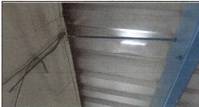
Foto 2: Sustrucción de metal por metal
