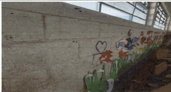
Foto1: Pintura en muros interiores
