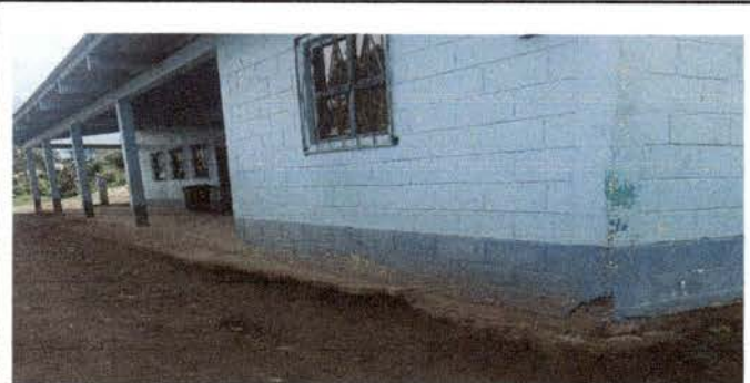
Foto 5: Reparación de banquetas de concreto
