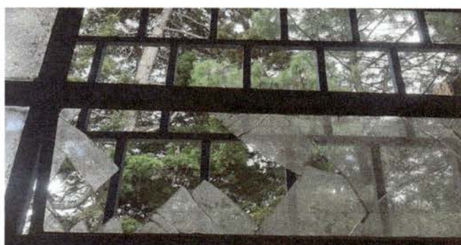
Foto 4: Sustrucción de vidrios
