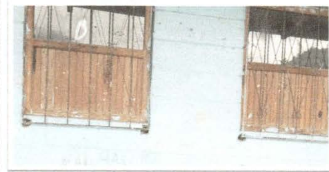
Foto 3: Sustrucción de ventana de madera por metal
